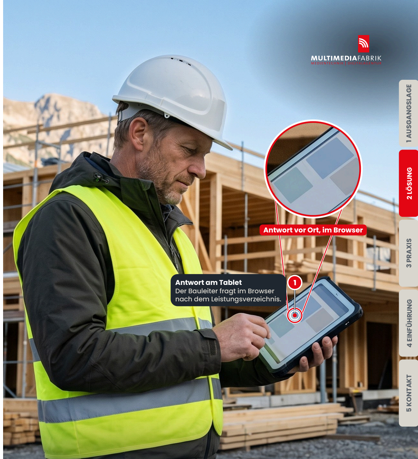
ABB. 10 Bauleiter mit Tablet auf der Holzbau-Baustelle
